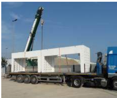
arrivo dei manufatti SIS in cantiere
