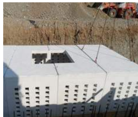
fasi di montaggio
