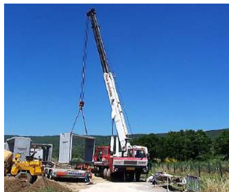
arrivo scatolari sul cantiere
