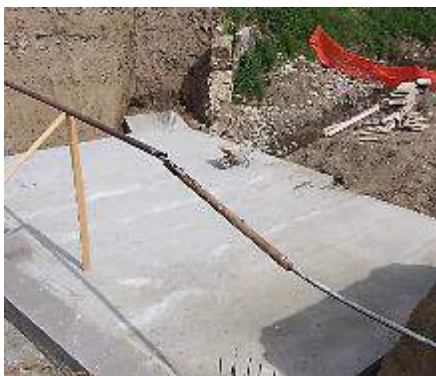
realizzazione platea di posa scatolari
