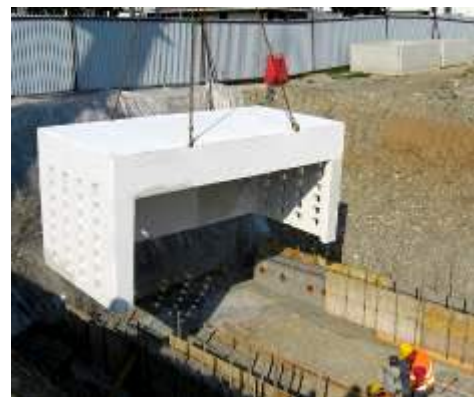
posa elemento di testata SIS
