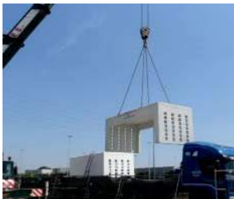
fasi di movimentazione degli elementi
