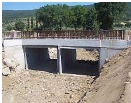
lavoro finito e ripristino viabilità
