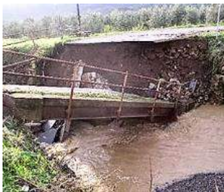
ponete crollato a seguito alluvione
